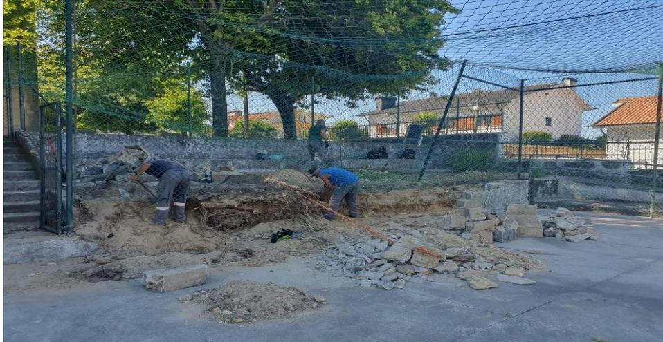
Esta intervenção da responsabilidade da Junta de Freguesia, contempla demolição e reconstrução do muro de suporte lateral, colocação de novas balizas, arranjo de redes de vedação e marcações de pavimento.
